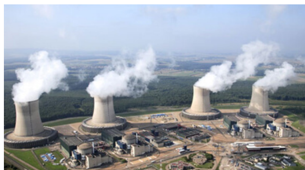
Centrale nucléaire de Cattenom, France
